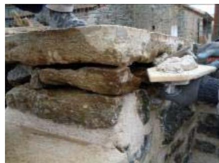
*Calage à l'aide de pierres et jointoiement à la chaux*
