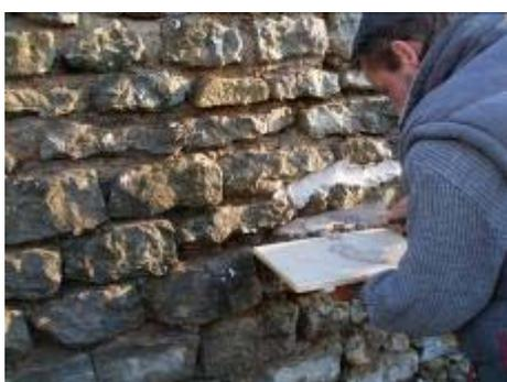
Ensuite, garnissage des espaces entre les pierres au moyen d'un mortier de chaux et à la langue de chat (petite truelle).
