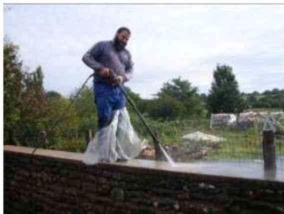
Brossage du plus gros à la brosse métallique puis passage du nettoyeur haute pression, afin que l'enduit accroche convenablement.
