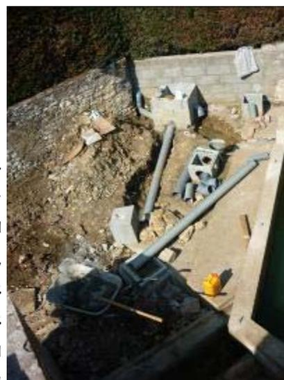
tranchée, surprise, de l'eau suinte du sol à chaque coup de pioche. Du coup, il a fallu créer un réseau de tuyaux pour drainer les écoulements et les résurgences de tout le terrain.
