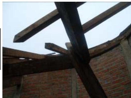
Abdel à la pose d'un des arêtiers créés en remplacement des angles en aggloméré.
