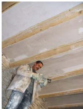
Sur les voûtaines, nous avons d'abord fabriqué un gabarit en mesurant les arcs de cercle des voûtaines existants, puis crée le gabarit en carton que nous avons reporté sur 2 pièces de bois avec 8 liteaux de longueur de 1 mètre pour faire un essai avec les briques. Une idée pour moi : c'est de mélanger le plâtre avec de l'enduit pour qu'il ne sèche pas tout de suite. Kamel
