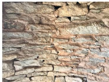
Piquetage et jointoyage intérieur après reprise des fissures.
