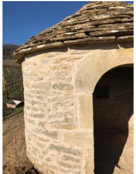
Reprise complète des maçonnerie de l'ouverture pour recallage en intérieur et à l'extérieur. Remaillage des maçonneries périphériques. Injection de coulis de chaux. Réalisation du jointoyage
