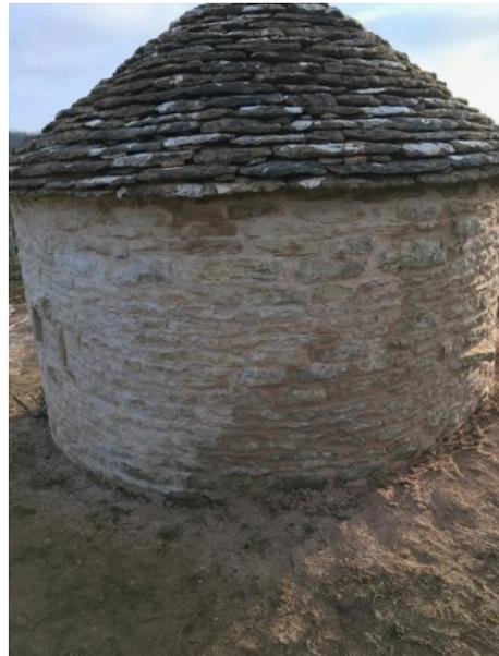
Piquetage et jointoyage des maçonnerie extérieures à la chaux légèrement teintée dans la masse.
