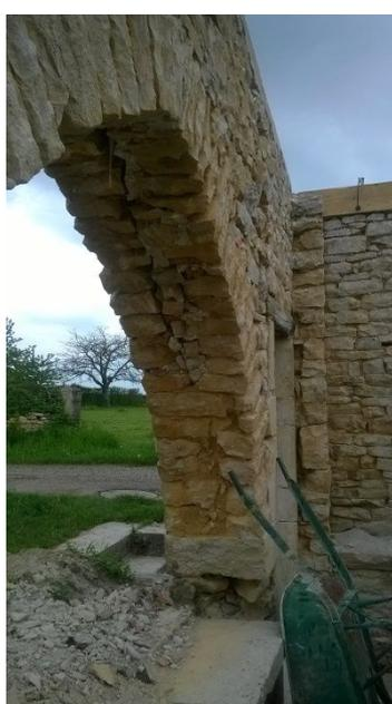
Les banc de pierres ont été entièrement restaurés : remplacement des pierres manquantes ou trop dégagées et scellement pour recalage et remise à niveau.
