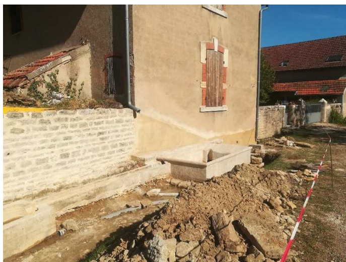
Piquetage, reprises, jointoyage et enduit du mur périphérique.
