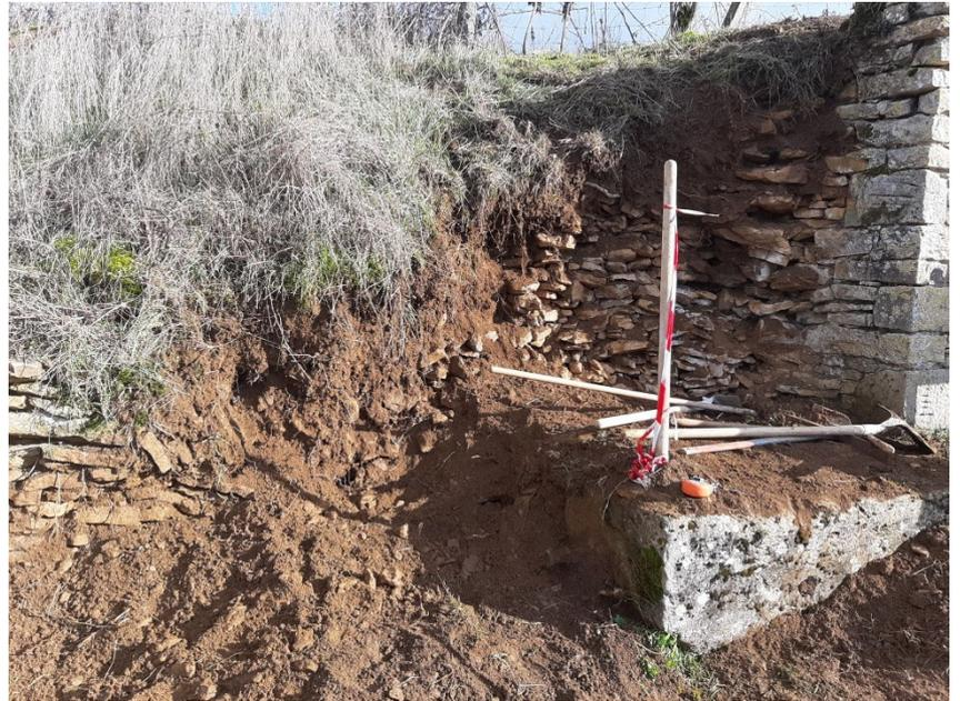
Remontage des deux murets latéraux avec création de barbacanes pour l'écoulement des des eaux afin d'éviter la pression du terrain.
