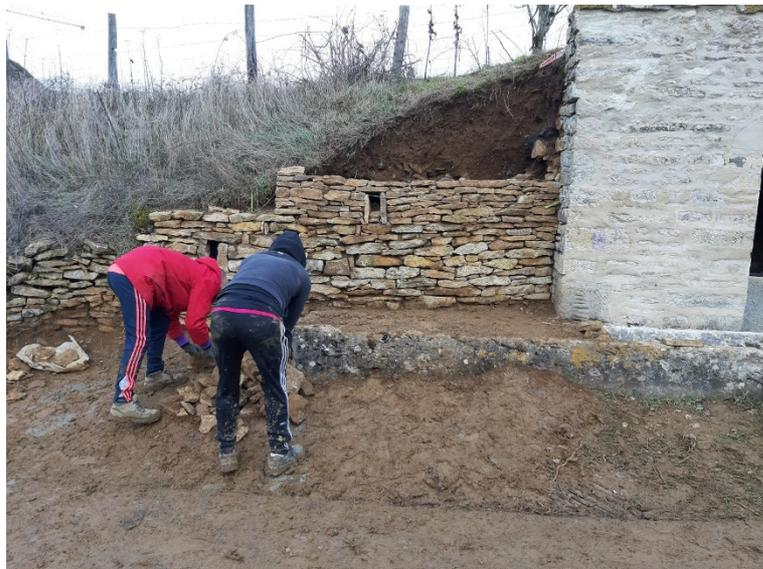
Réalisation du jointoyage de façade à la chaux hydraulique légèrement teintée dans la masse, réalisation d'un enduit sur le muret central. Et pose d'un pavage.
