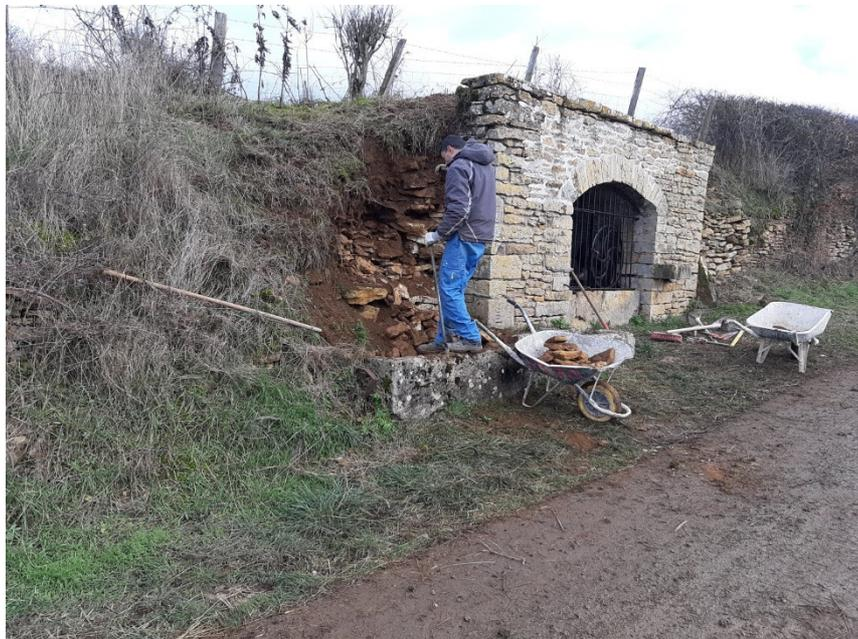
Dégagement de la végétation au dessus et autour de la fontaine et dépose des murs en pierre sèche sur les parties latérales.
