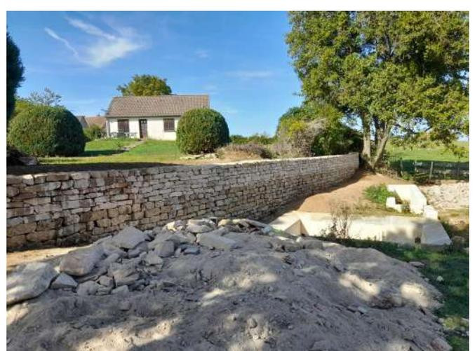
Reprise des maçonneries des trois bassins, jointoyage et enduit,
