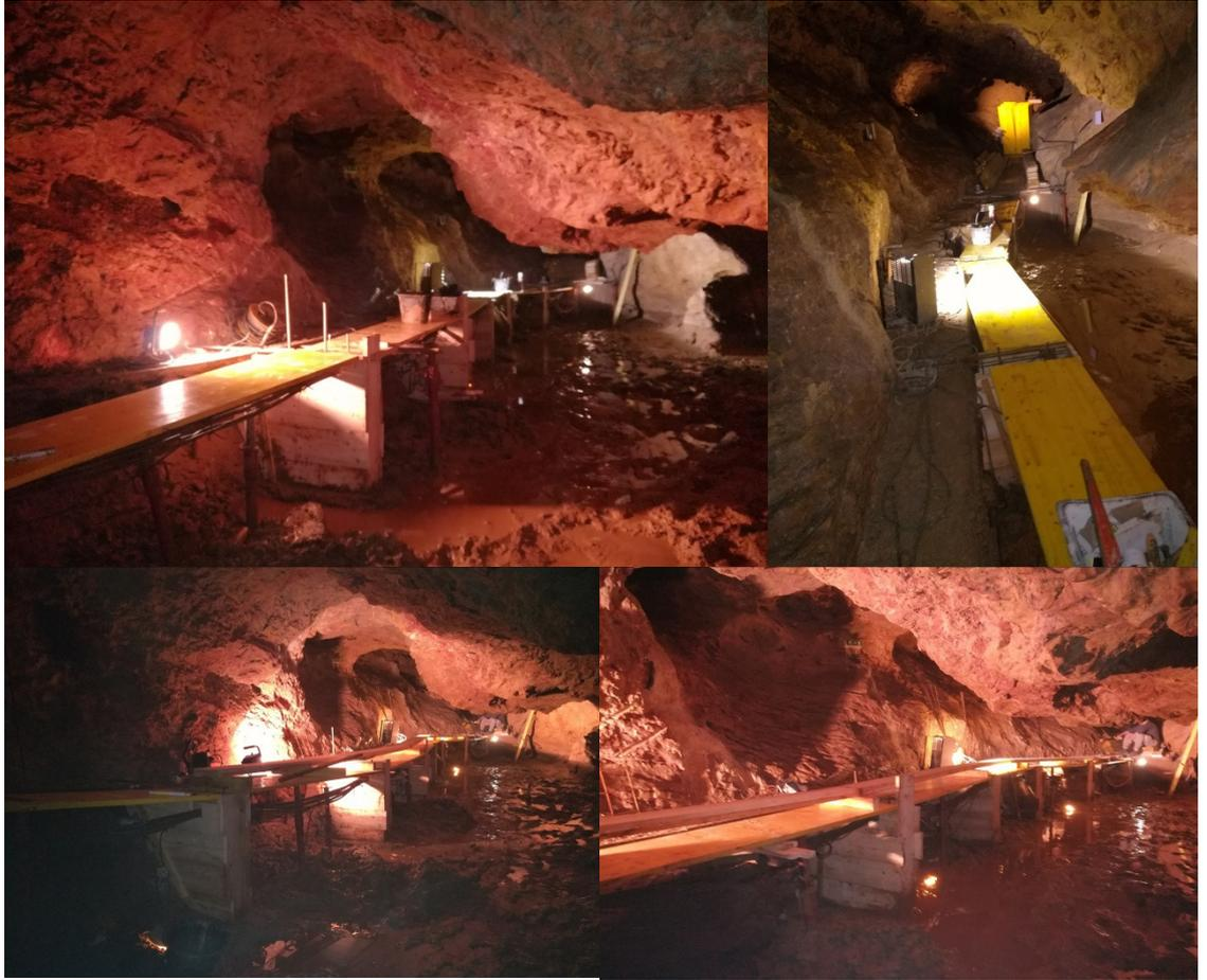
Le coffrage terminé et les plinthes posées nous avons pu procéder au ferrailage posé sur un polyane et couler le béton.
