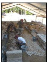
Des lignes de pierres sont montées les unes après les autres dans un calibre de parement différent, pour finir par ce que nous appelons un chapeau. Ce dernier est maçonné de façon à ce que l'eau de pluie s'écoule facilement pour qu'il n'y ait pas de poche d'eau qui gèlerait l'hiver et fragiliserait le mur.
