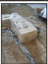
Les granites délimitant les entrées des pièces et les angles sont rehaussés et recollés. On termine par jointoyer les murs. Bien sûr, nous déplaçons nos abris de pièce en pièce pour pouvoir travailler par tous les temps.
