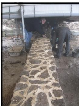
Nous avons démonté un gabion pour laisser la place à un escalier en tôle qui, nous l'espérons, ne vas pas tarder à être livré, ce qui permettra de finir les terrassements du jardin et de poser les colonnes.
