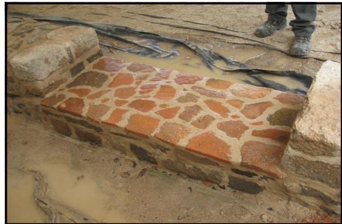
La restitution des seuils dépend de ce que les archéologues trouvent lors de la fouille. Un autre, plus grand, est restitué sur les restes de l'original protégé par un géotextile. Il règle le passage de la pièce dans l'atrium.
