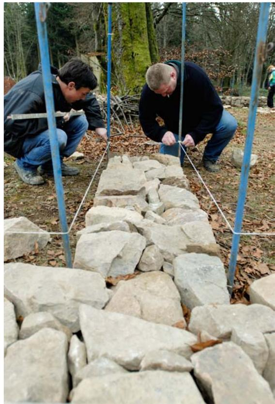
L'apprentissage du montage de murs en pierres sèches permet tout d'abord de développer les capacités de chacun qui ne sont pas forcément les mêmes. Ensuite, il y a des difficultés qu'il faut surmonter dans la construction en ayant une bonne visualisation des formes et des fonctions de chaque pierre. Lorsque tous les apprentissages sont faits, on peut s'attaquer à la structure du mur afin que celui-ci soit construit très solidement.
