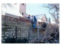
Pour atteindre notre objectif, nous avons commencé de monter un ensemble d'échafaudage de 35 mètres de long. Ensuite nous avons trié les pierres afin de les poser les unes sur les autres puis nous avons tendu des cordeaux sur le mur. Nous avons utilisé de la chaux hydraulique qui a été préparée dans une bétonnière.
