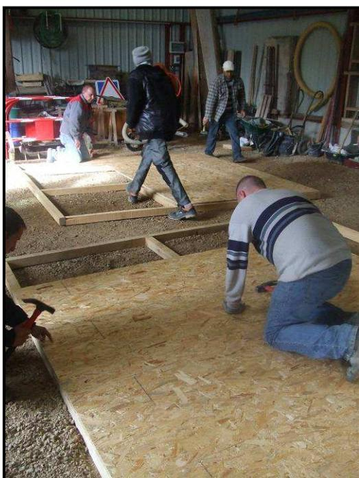
Puis, nous avons pris les mesures des pièces de charpente pour les reporter sur le plancher afin de réaliser la nouvelle charpente en chêne (création d'épures). Les pièces en bois ont été reproduites à l'aide d'un gabarit (idée apportée par Eric, après une première tentative qui fut un échec). Une fois toutes les pièces reproduites, nous avons assemblé à blanc la nouvelle charpente à l'aide de tourillons (chevilles en bois).
