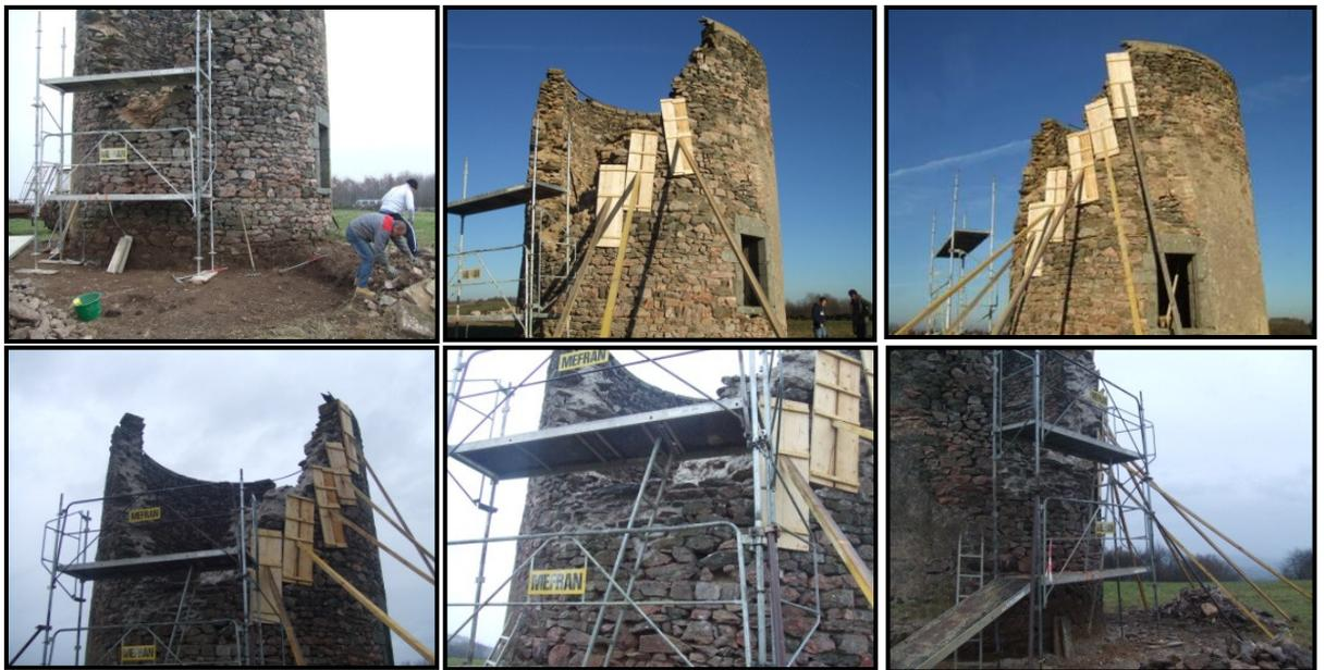
Les parements extérieurs et intérieurs ont été remontés rang par rang avec blocage intérieur à la chaux hydraulique et les différents fissures ont été entièrement reprises avec des coulis de chaux.
