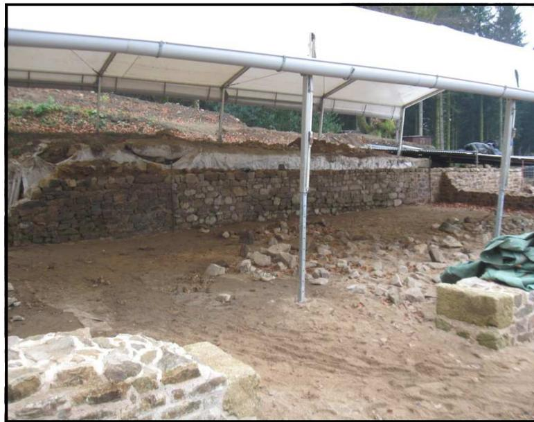
Une fois arrivés à la hauteur du mur restitué le mois dernier, on réalise une étanchéité sur le dessus. Le froid étant annoncé ces prochains jours, nous le protégerons pour l'hiver à l'aide d'un géotextile et de bâches plastiques. Les derniers rangs seront faits l'année prochaine, ainsi que les joints.
