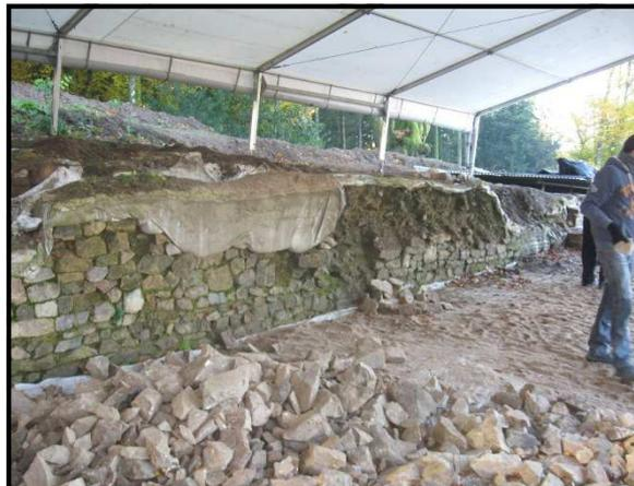
le géotextile dans les pièces qui viennent d'être fouillées. Ensuite nous y mettrons de la terre. On nettoie soigneusement le mur en débarrassant les pierres du mortier antique pour une bonne accroche. Nous montons les parements ligne par ligne et réalisons le bouchage intérieur en même temps.
