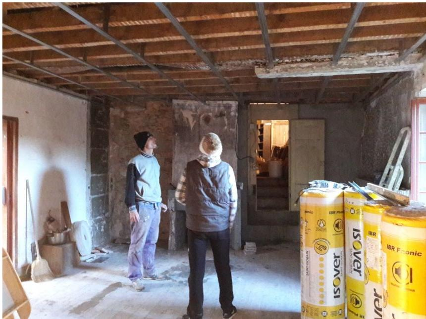
Nous venons de terminer la pose des rails après avoir découvert l'utilisation du laser pour s'assurer de l'horizontalité du futur plafond. Nous devons maintenant passer les gaines électriques avant d'isoler et de visser les premières plaques de placo-plâtre.
