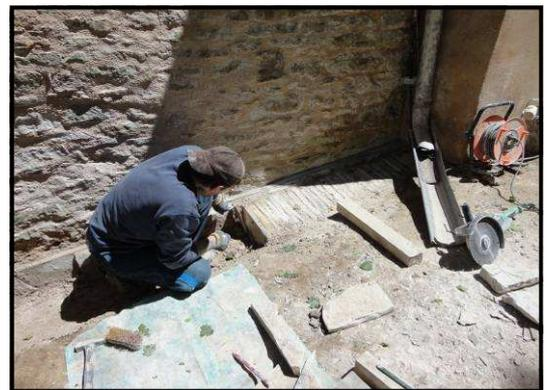
Nous avons également prévu de réaliser des terrasses dallées devant les entrées de Revermont. Nous avons décaissé 18 m<sup>2</sup>, préparé le coffrage et installé le treillis soudé. Mais la pluie nous interdit de réaliser nos travaux dans de bonnes conditions, et nous les avons donc suspendus en attendant des jours meilleurs. Pareil pour le caniveau en pierres dressées que nous voulions réaliser le long du chemin.
