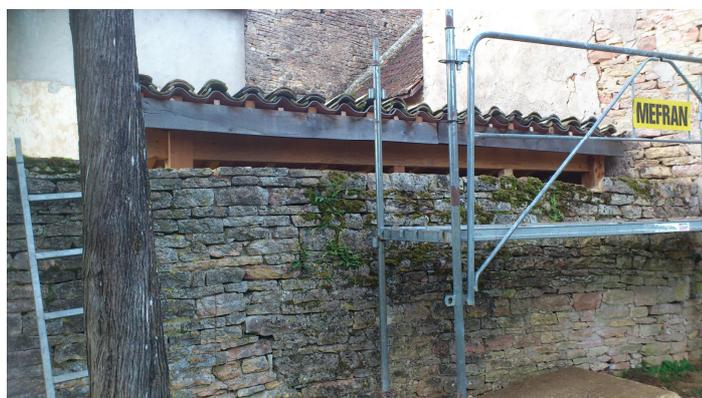
Ce chantier terminé, nous avons repris le chemin de l'église de Cortiambles pour une nouvelle opération. Cette fois-ci nous devons restaurer et rehausser un mur de clôture. Il s'agit dans un premier temps de poser quelques rangs de pierres, en mauvais état, de redresser et consolider les rangs avant de rehausser le mur de 60 cm, sous le regard attentif de François. La fin de ce chantier est prévu pour le 15 mars.
