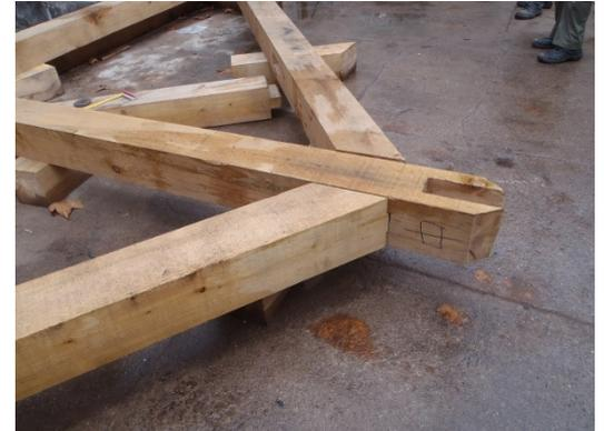
Un assemblage à blanc nous a ensuite permis de corriger les écarts et de vérifier que les éléments s'ajustent parfaitement.
