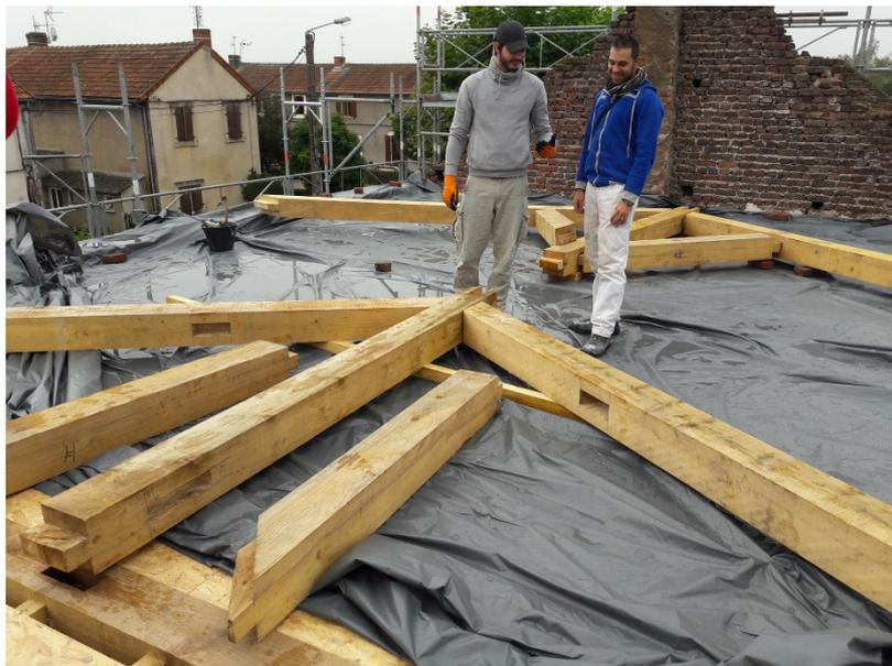
A l'aide d'un palan nous avons hissé sur ce sol les éléments des deux fermes que nous avons assemblés après avoir réalisé les quelques ajustements nécessaires au bon emboîtement dans les entrails.
