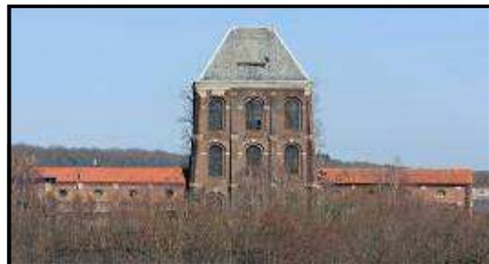
Le puits Hottinguer était l'un des principaux charbonnages des houillères d'Épinac. Les bâtiments ont été construits entre 1872 et 1876 et abritaient un mode d'extraction par un système atmosphérique révolutionnaire : piston se déplaçant dans un tube de 558 m de hauteur, usiné au Creusot (technique originale de l'ingénieur Zulma Blanchet) et non par câbles traditionnels qui ne permettaient pas, à cette époque, de descendre aussi bas (plus de 600 mètres).
