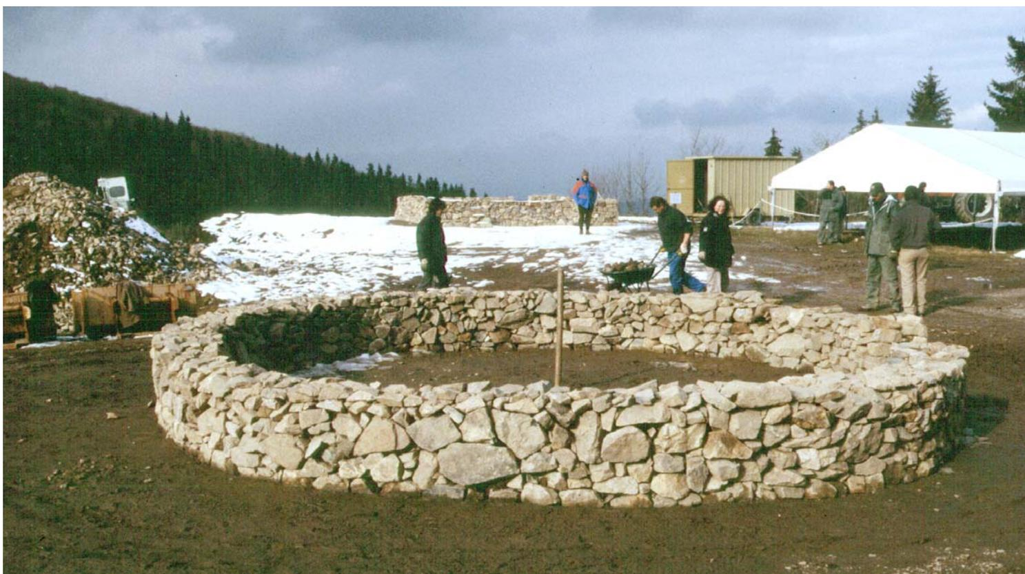
nous a pas empêchés de construire un mur circulaire de 6 m de diamètre et de 0,60 m de hauteur, comportant une porte. Il a été plus difficile de trouver les pierres adaptées, sachant que les plus belles étaient utilisées dans le mur carré. Pour le mur rond, la technique mise en œuvre a été différente des murs précédents. En effet, l'assise était constituée de pierres de taille moyenne et de plus grosses au fur et à mesure de l'élévation.
